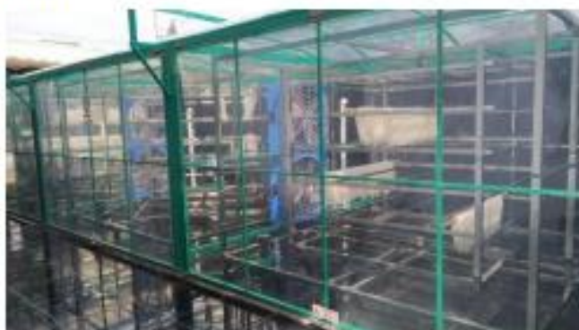
Hình 4. Hệ thống đèn UVC khử vi sinh, nấm mốc trong buồng sấy
